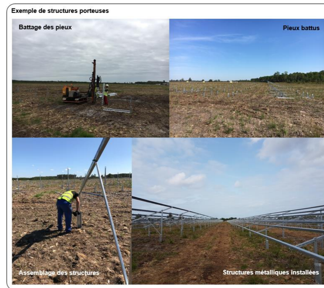
Figure 65 : Structures porteuses métalliques
