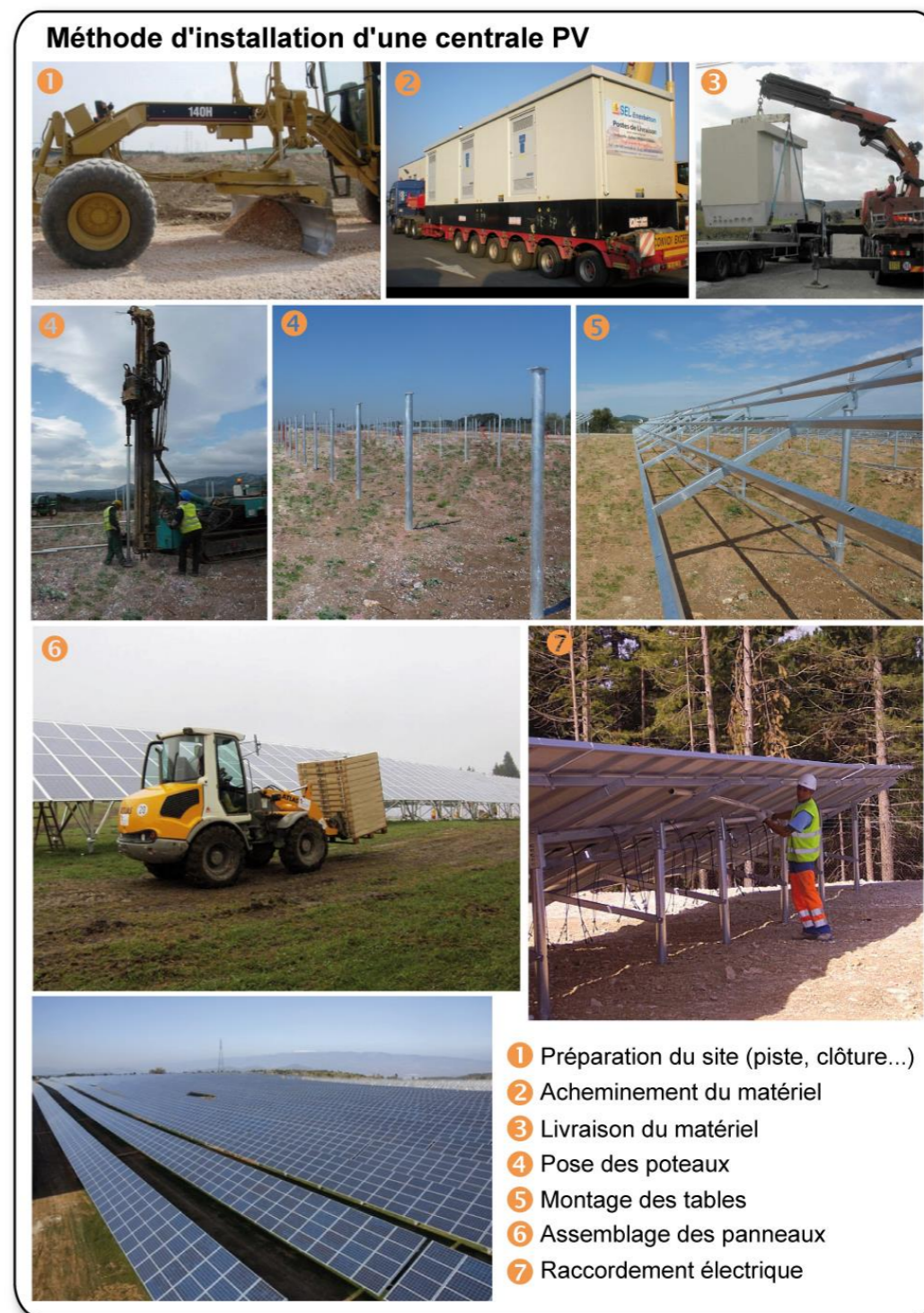
Figure 74 : Construction d'une centrale photovoltaïque au sol
