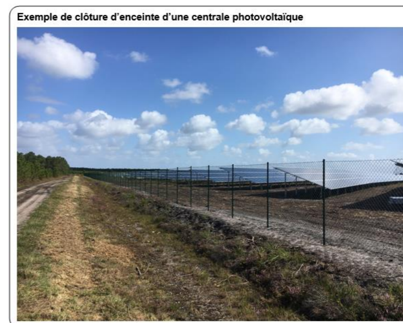
Figure 71 : Clôture de sécurité
